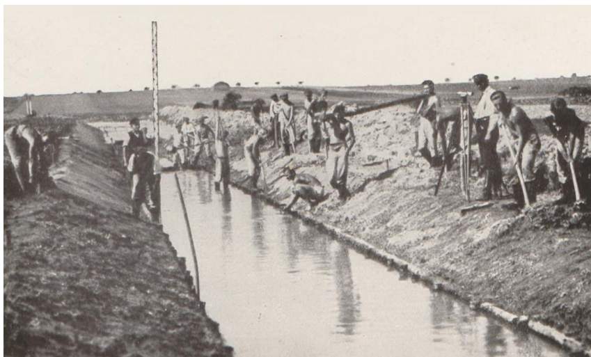
Mitglieder des RAD helfen bei der Herstellung eines Entwässerungsgrabens zwischen Feldern
